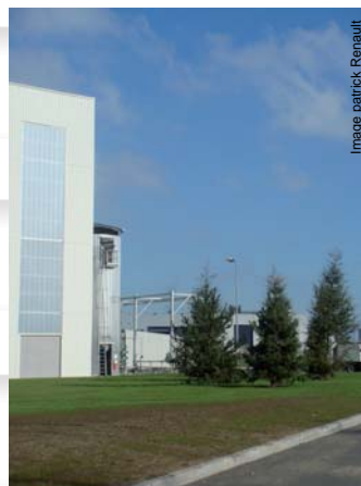
Espaces techniques de l'usine
