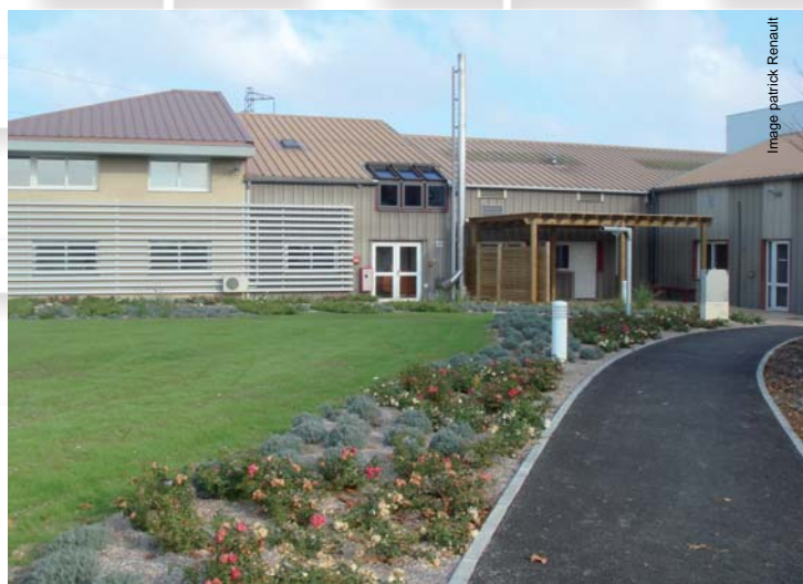
Allée d'accès depuis le parking salariés
